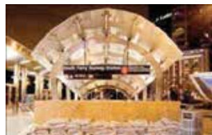
Des sacs de sable et des planches pour protéger une bouche de métro.
