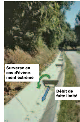
Figure 9 : Fossé avec limiteurs de débit, mais permettant l'écoulement des eaux en surplus en cas d'événement extrême. Photo d'origine : Yves Nédélec.
