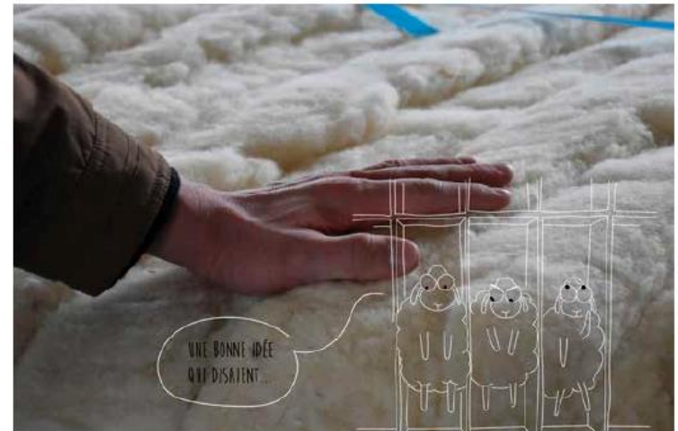
Visite du chantier de la salle des fêtes de Mandres-aux-Quatre-Tours
