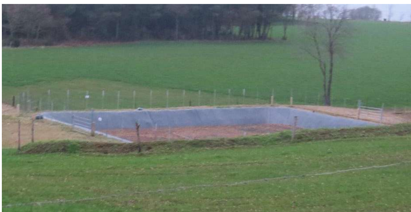
Exemple de fosse pour stockage d'effluents d'élevage (fosse à géomembrane)
